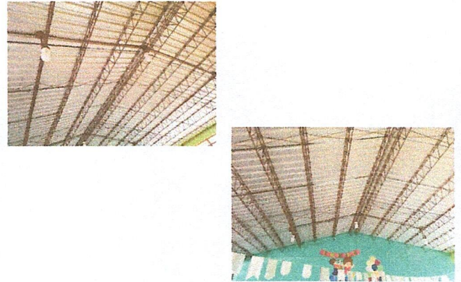
Foto 4: Remozamiento de sistema electrico
