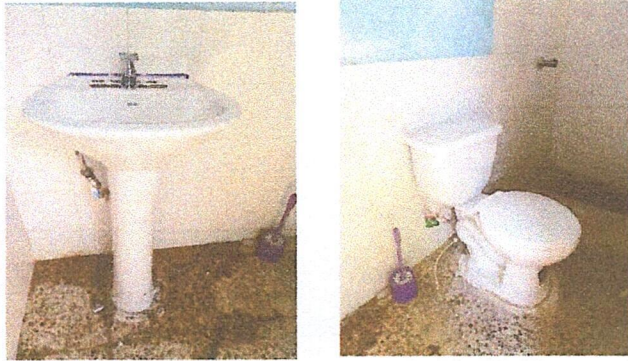
Foto 1: Remozamiento de servicios sanitarios
