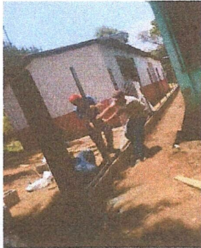
Foto 3: Remozamiento de muro perimetral
